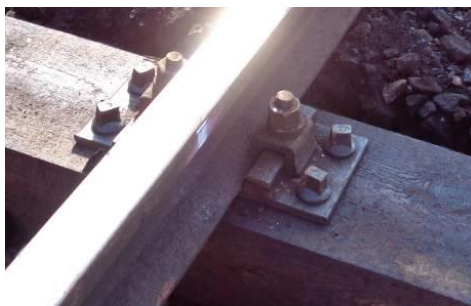
Rys. 4b. Przytwierdzenie pośrednie typu „K”. 1 – szyna, 2 – przekładka podszynowa, 3 – śruba stopowa, 4 – łapka, 5 – wkręt, 6 – nakrętka, 7 – pierścień sprężysty, 8 – podkładka żebrowa, 9 – podkład.
