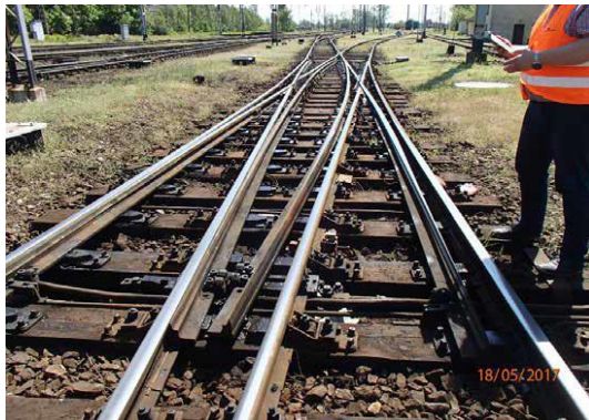
Rys. 16a. Zwrotnica rozjazdu krzyżowego podwójnego
