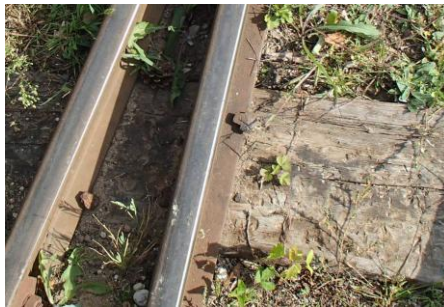
Rys. 4a. Przytwierdzenie bezpośrednie szyny S42 do podkładów drewnianych. 1 – szyna, 2 – podkładka żebrowa, 3 – wkręt, 4 – podkład drewniany.
