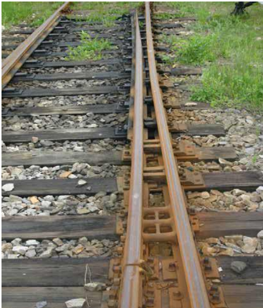
Rys. 13a. Zwrotnice z iglicami sprężystymi Rys. 13b. Zwrotnice z iglicami szynowo-sprężystymi
