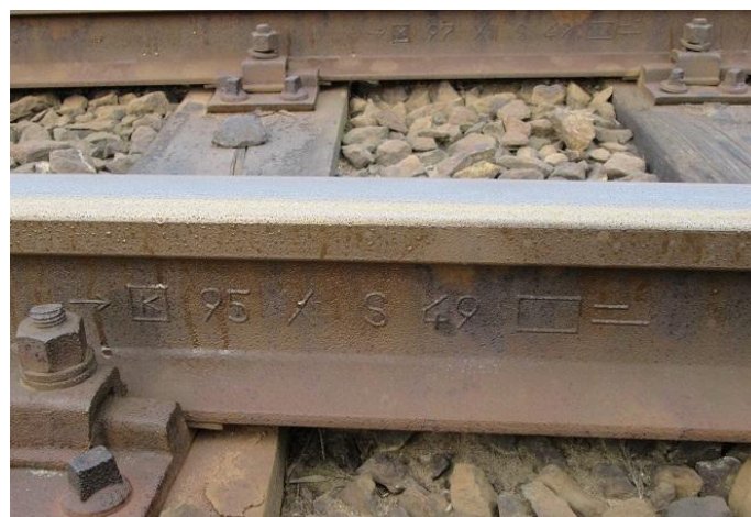
Rys. 3. Cechowanie szyn S49 (49E1).
